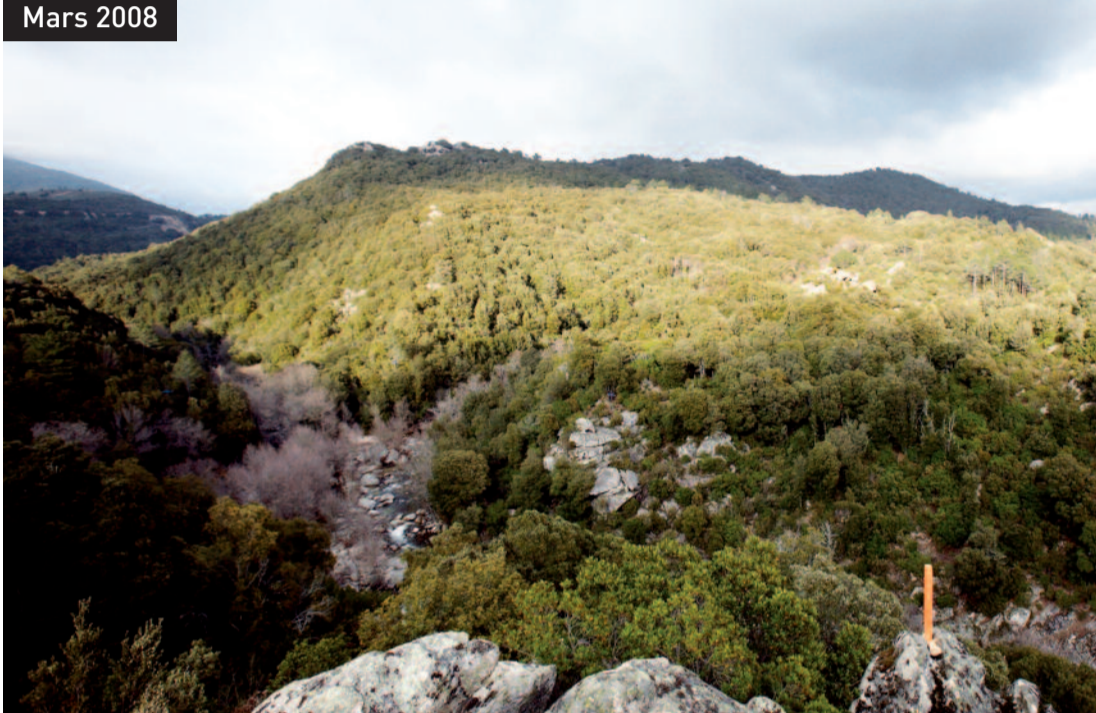
Le site du barrage - Mars 2008
