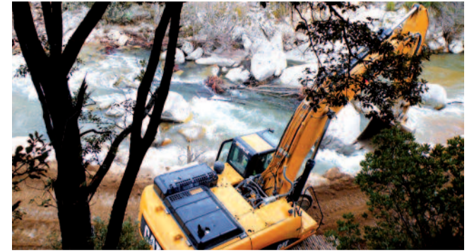
Pelleteuse dans le lit du Rizzanese
