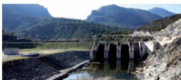
Le barrage de Sampolo
