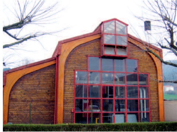
Chaufferie bois à Langeac
