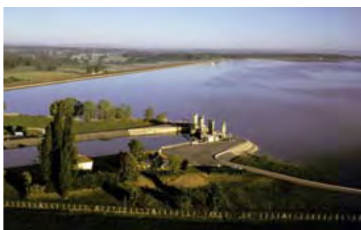
Lac Seine : déversoir d'extrémité du canal d'amenée.
