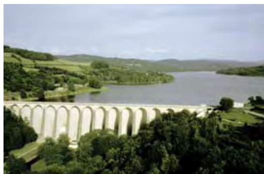
Barrage de Pannecière IIBRBS, P. Pérouse – 2002.
